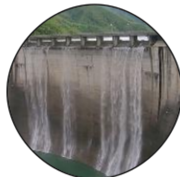
Diga di Ridracoli la cascata sul lago
